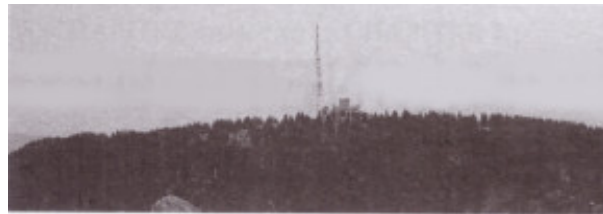
FIGURE 3 – Émetteur de la Barillette
